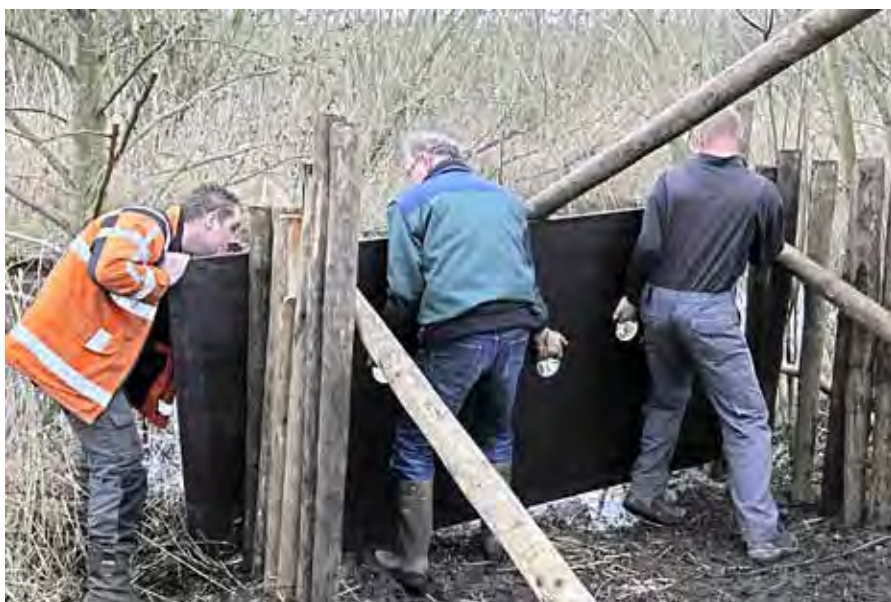
Plaatsing van de broedwand.
