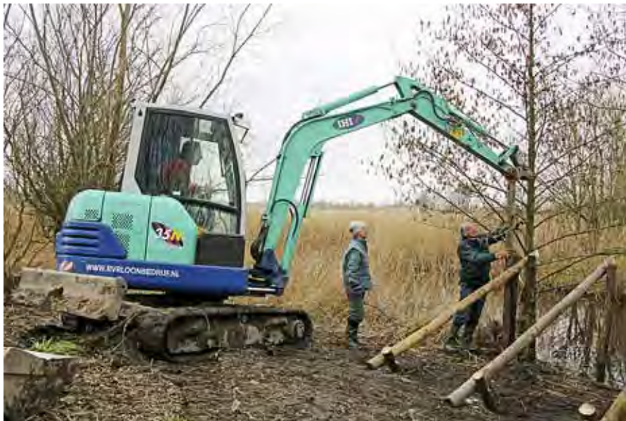
Machinaal worden de palen de grond in geslagen.
