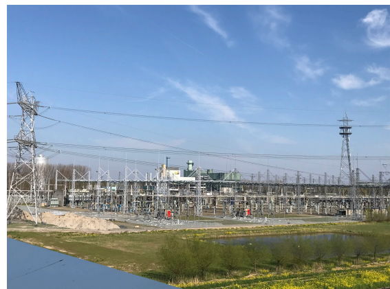
Transformatorstation bij Centrale Diemen
